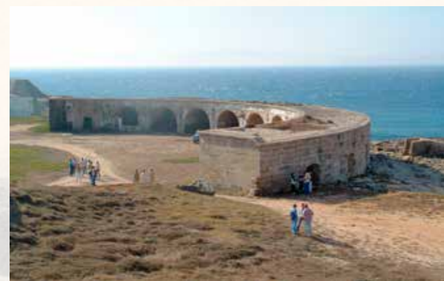
La batería acasamatada de Poniente o batería de Daoiz y Velarde 1858-1861
